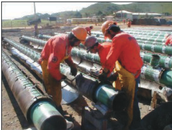
Figura 9.6.1 – Concretagem da jaqueta
