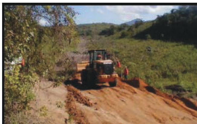
Figura 9.2.1 – Abertura de pista
