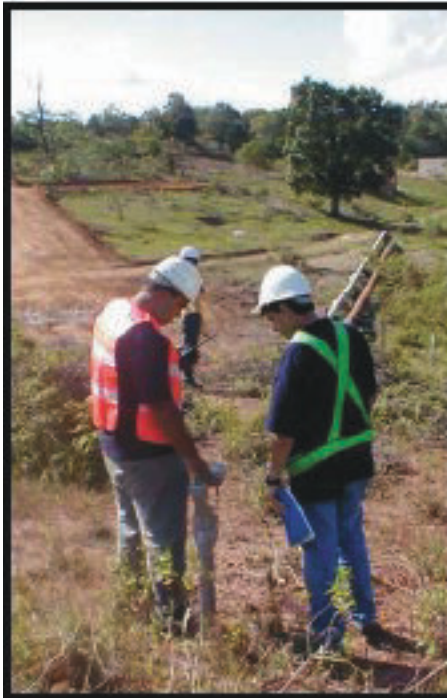
Figura 9.3.1 – Pipe-locator sobre a diretriz do duto
