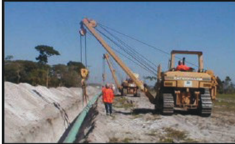
Figura 10.1 – Abaixamento de dutos
