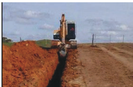
Figura 9.5.1 – Abertura de vala por escavadeira
